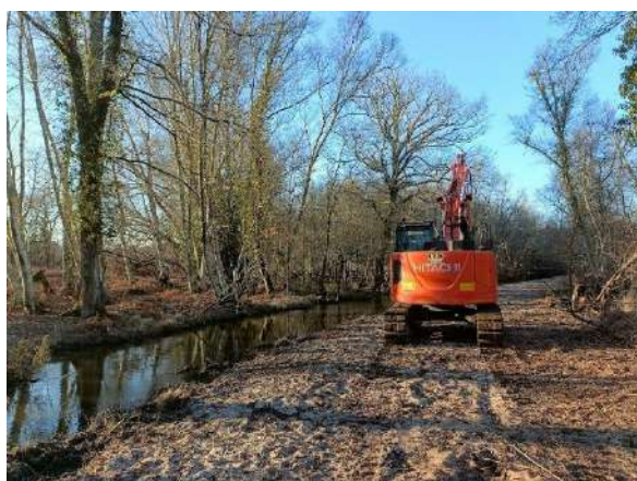
Exemple d'un merlon réalisé dans le cadre des travaux de reconnexion des zones humides attenantes à l'aval du bassin versant de la Caillava
