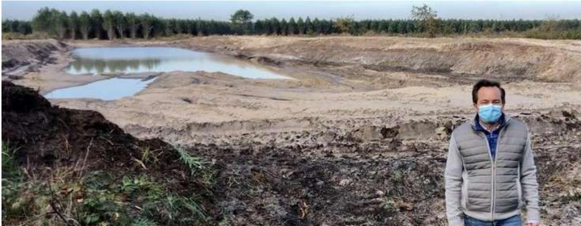
Travaux 2021 sur des lagunages agricoles – Domaine St Jean – Hourtin
