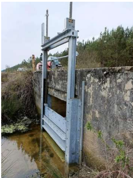
Ecluse en aval direct des plaines agricoles sur le fossé Saint-Vincent
