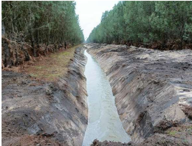
Travaux de reconnexion du fossé du Jolles (1,2 km reconnecté).
