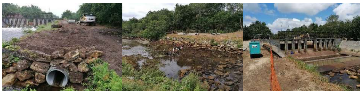
Installation de chantier, dérivation des eaux, pêche électrique et mise hors d'eau : juin
