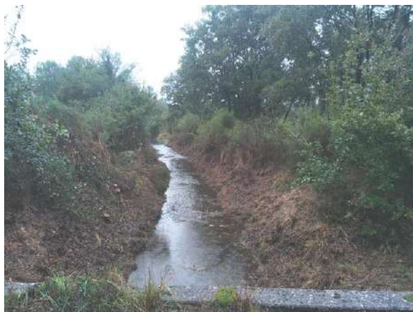
Remise en eau après intervention de l'entreprise
