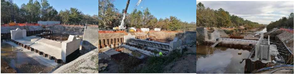
Pose du nouveau vannage et construction des passes à poissons : septembre à novembre
