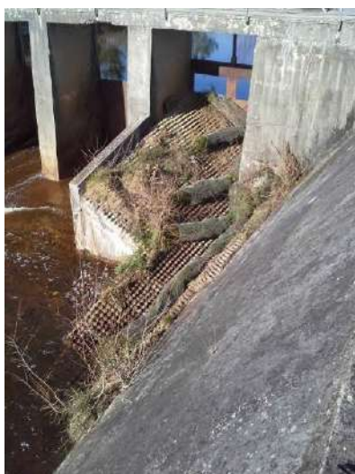
« Boudins de genêts » pour équipement passe à civelles- Mars - Mai 2021
