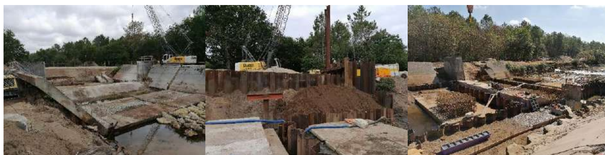
Démolition des anciens piliers, mise en place d'une enceinte de protection en palplanches et construction des nouveaux radiers et murs : juillet - août
