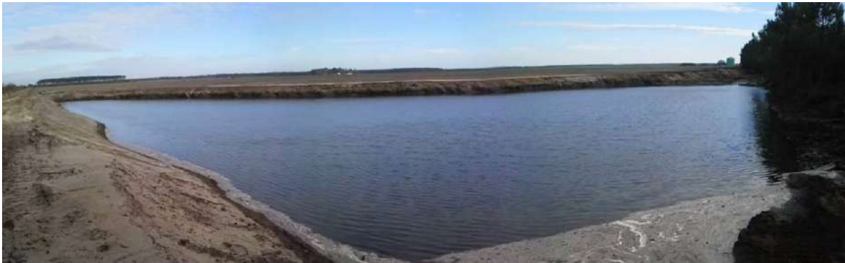
Travaux d'aménagement de lagunages tampons Domaine St-Jean - Hourtin
