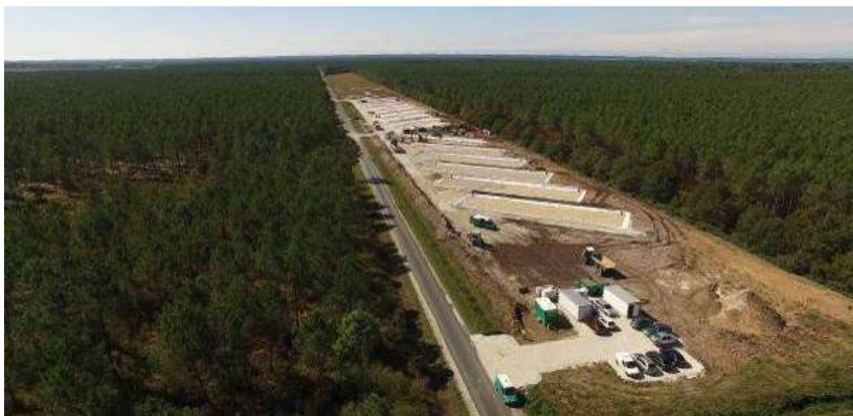
Station d'épuration de Carcans
