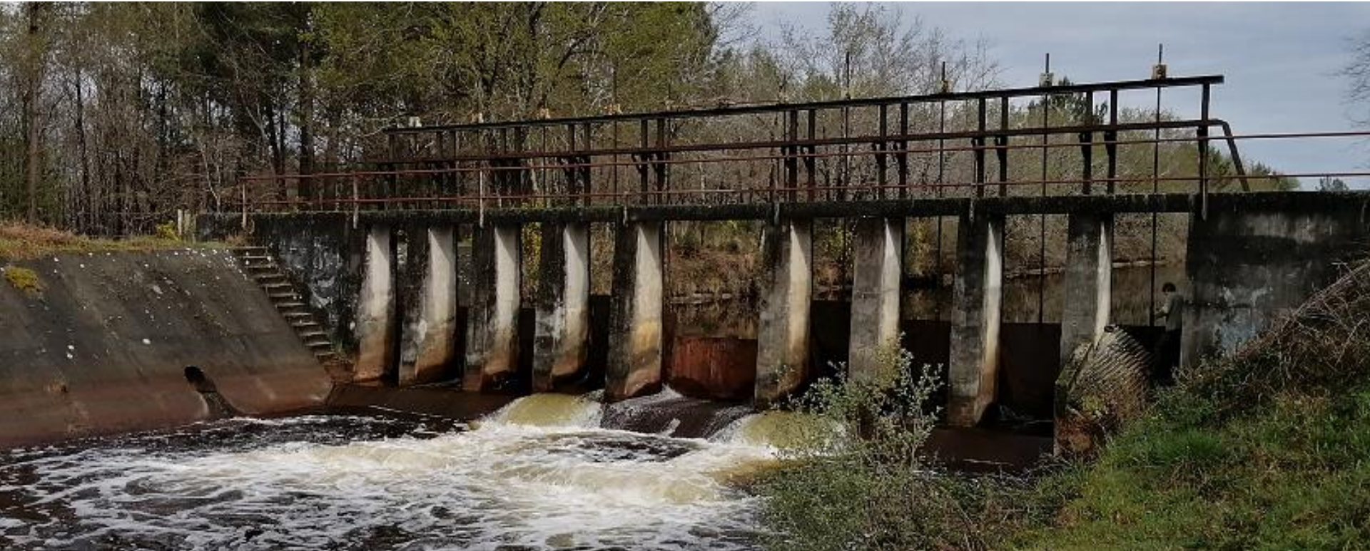
Ouvrage de Joncru avant les travaux
