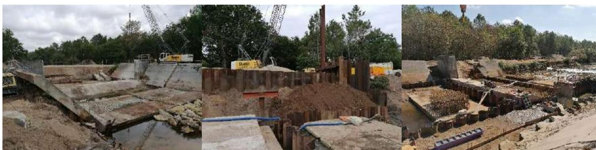
*Démolition des anciens piliers, mise en place d'une enceinte de protection en palplanches et construction des nouveaux radiers et murs : juillet - août*
