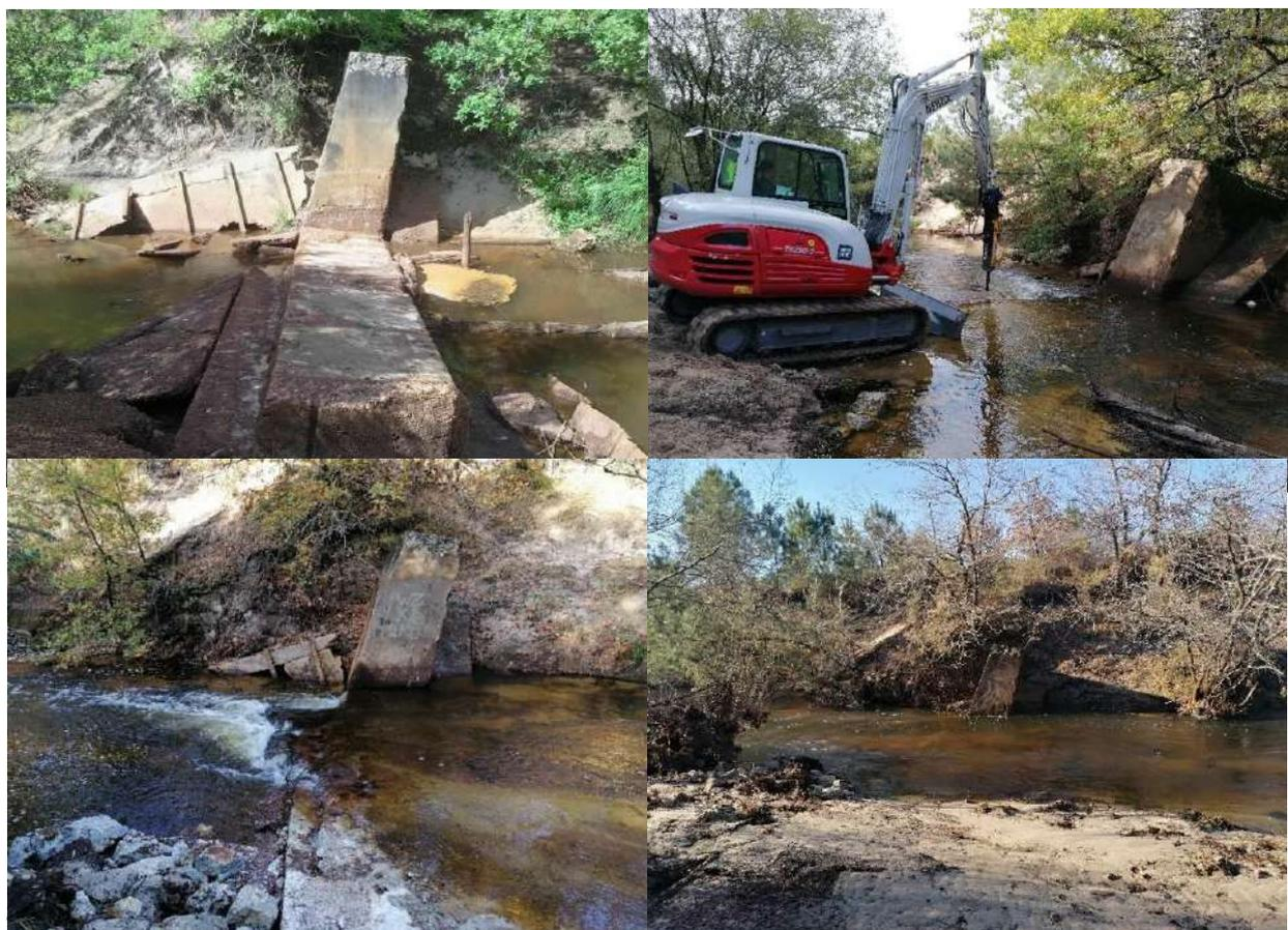
Les travaux ont été réalisés pendant l'automne 2021 en période d'étiage. Une minipelle a été utilisée pour supprimer le seuil béton de 0.5 m de hauteur et extraire les matériaux. Les palplanches ont été découpées à la disqueuse. La situation après travaux montre un très bon résultat avec une chute résiduelle en étiage de quelques centimètres qui ne posent pas de problème de continuité écologique. Cette chute est nulle avec des débits moyens et supérieurs.
